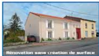
Rénovation sans création de surface
