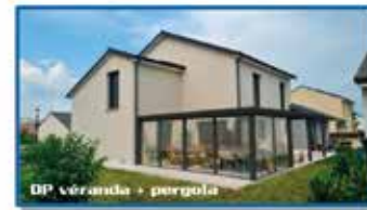
DP véranda + pergola
